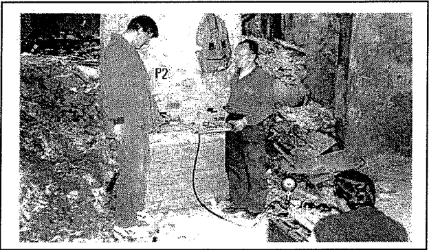
slika 8. Ispitivanje zidane konstrukcije pull-out metodom
